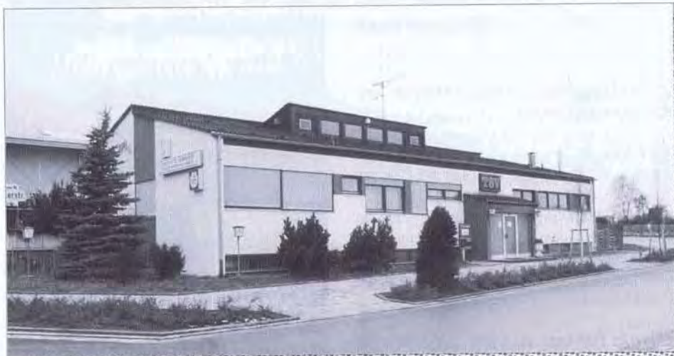
Das neue Vereinsheim: Zentrum und Geschäftsstelle in den Sandäckern.
